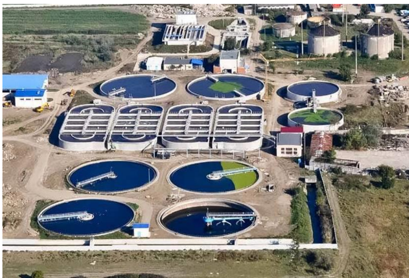
Figura 9.2 Stația de epurare Arad
