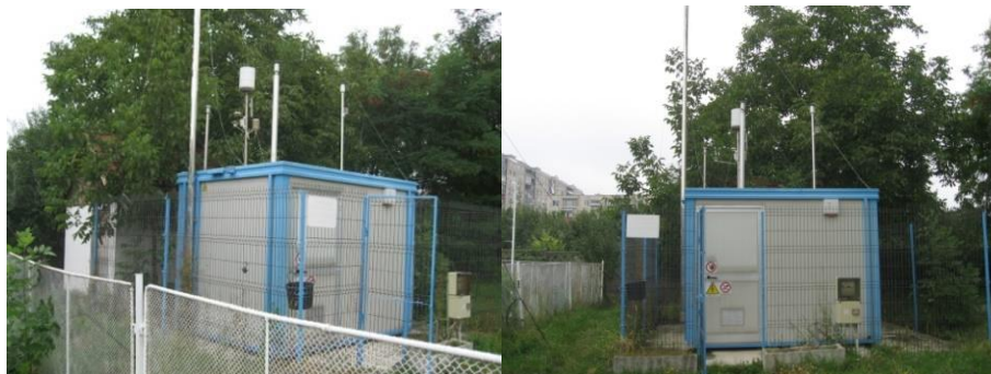
Figura 5.3 Stații de monitorizare a emisiilor în atmosferă
